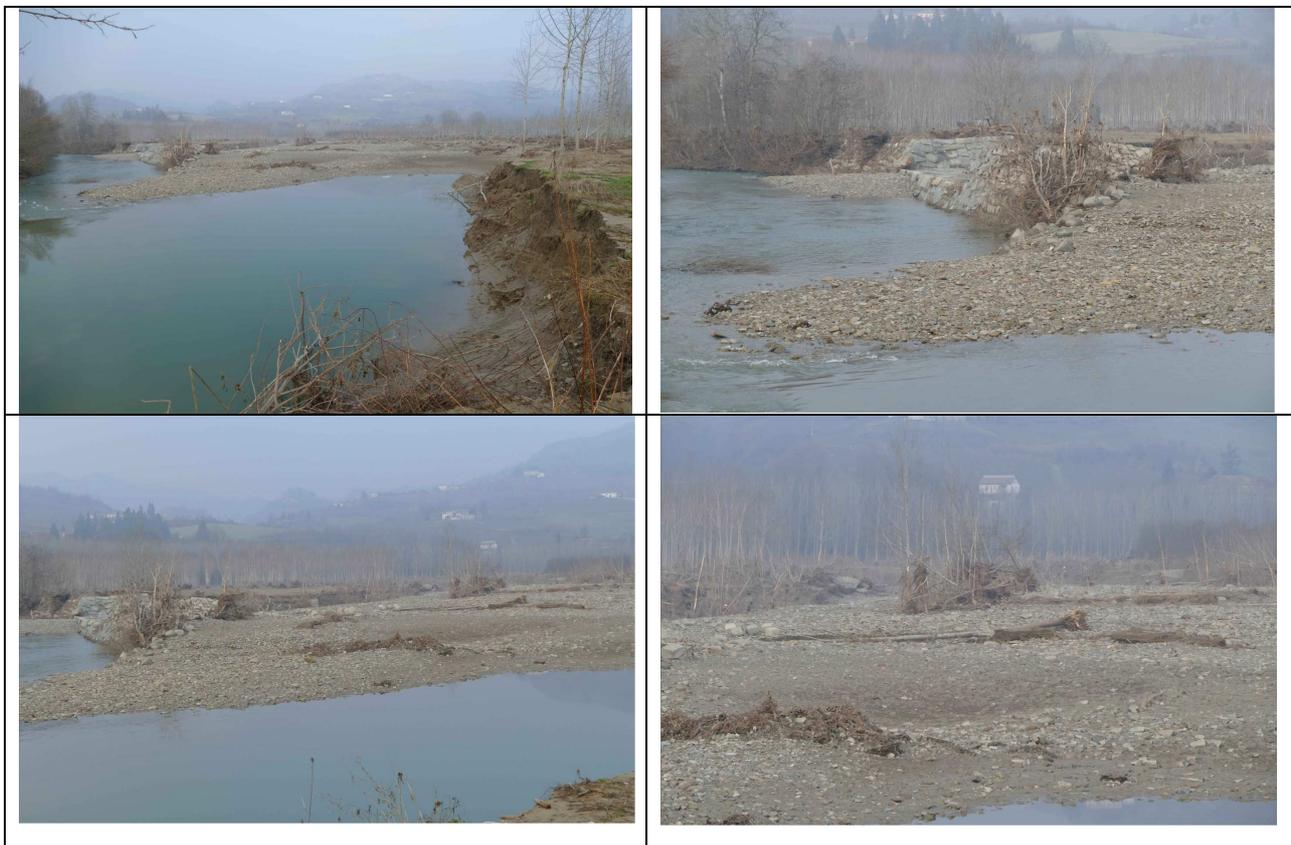
**Figura 26** – Riprese del 05 Dic 2016 – Taglio meandro in Sp. Dx. a monte dell’opera di protezione realizzata nel 2015 – Fonte: Studio Ing. Arnaud
