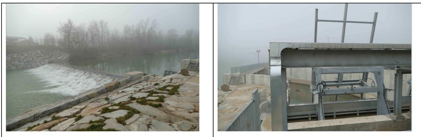
**Figura 28** – Riprese del 05 Dic 2016 – Recente traversa a Bistagno a valle della confluenza Bormida di Millesimo – Bormida di Spigno realizzata per la nuova Centrale Idroelettrica SEAM totalmente esondata con un tirante di circa 1 m superiormente alle paratoie in figura.
